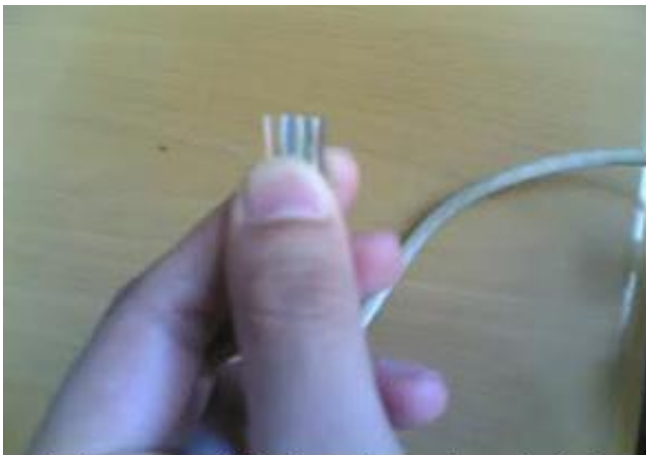
Kabel yang sudah diratakan ujung kabelnya
